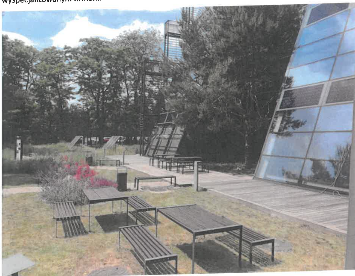
Fot. 7. Fragment elewacji południowej Budynku A wraz z infrastrukturą.
