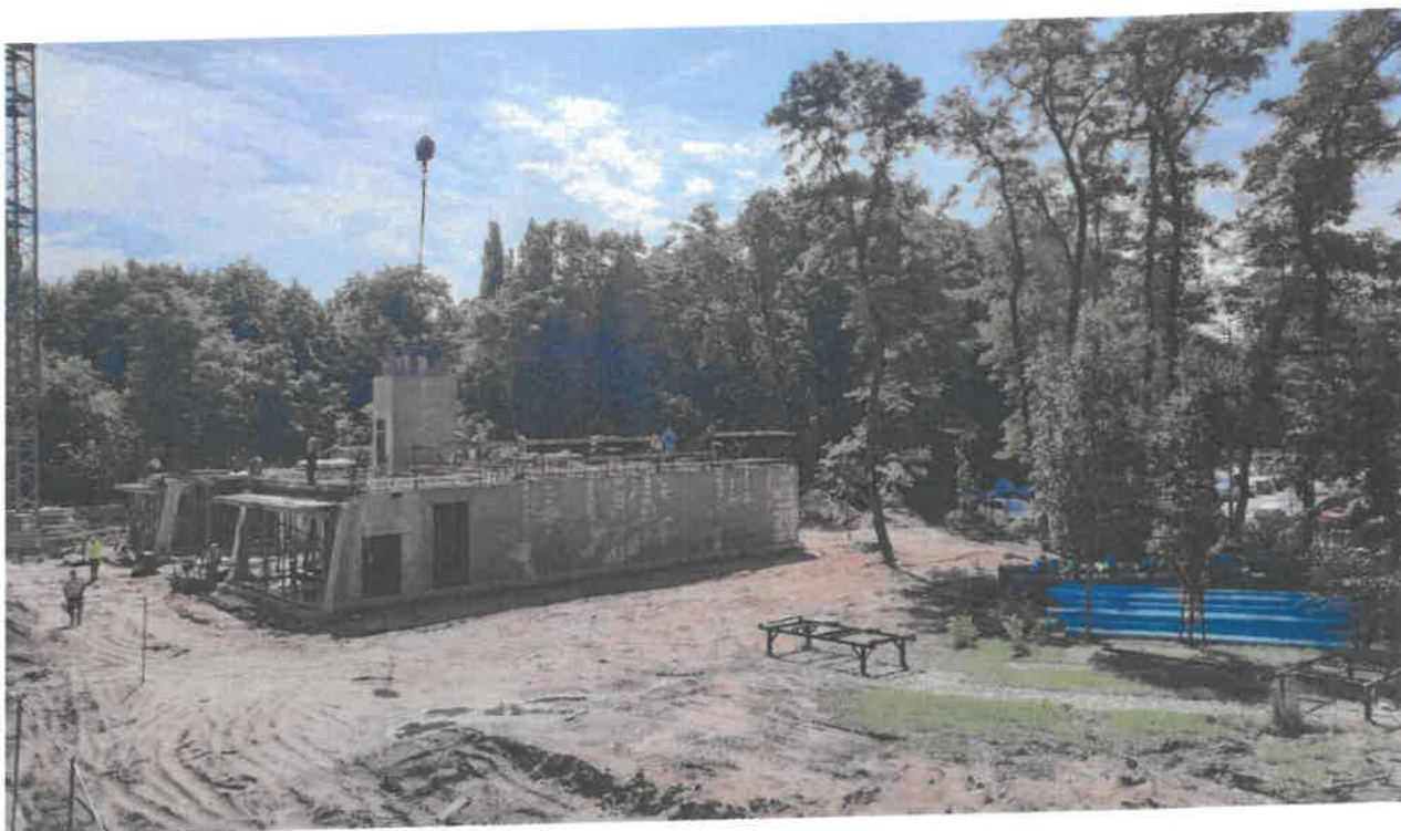
Fot. 11. Zamknięcie pierwszej kondygnacji Budynku B.
