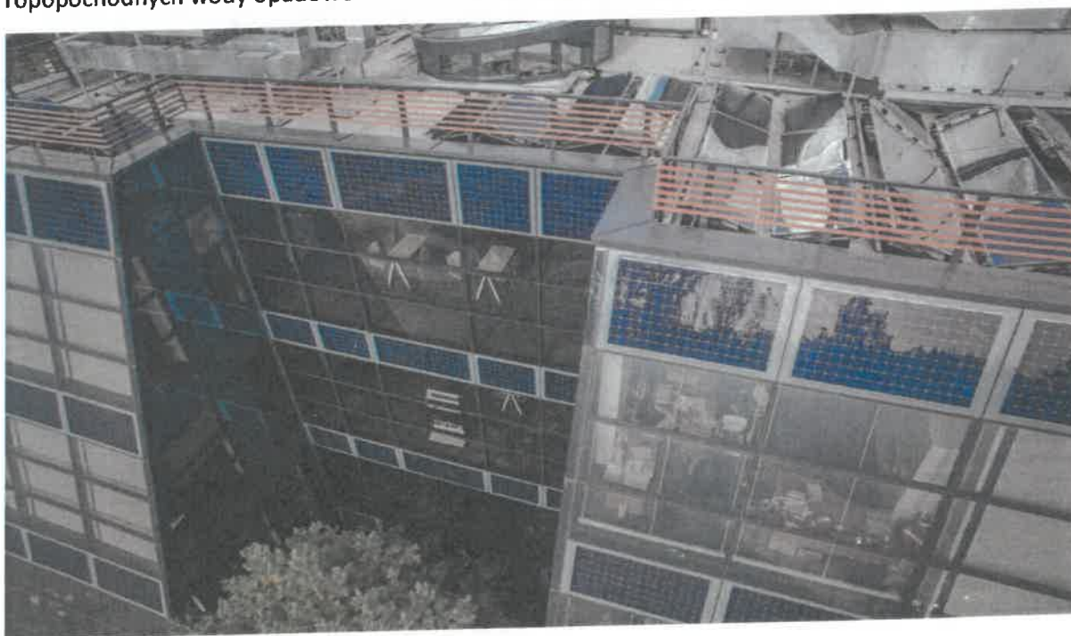
Fot. 6. Panele fotowoltaiczne na elewacji i dachu siedziby WFOŚiGW w Łodzi.
