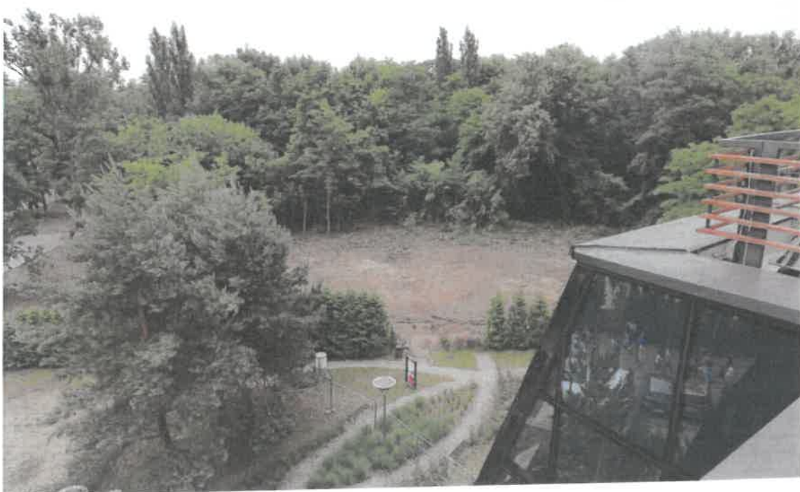
Fot. 9. Plac budowy przygotowany pod budowę Budynku B.
