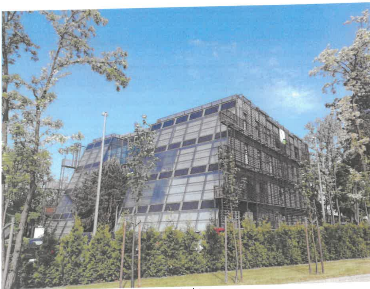
Fot. 1. Siedziba WFOŚiGW w Łodzi przy ul. Dubois 118 – Budynek A.
