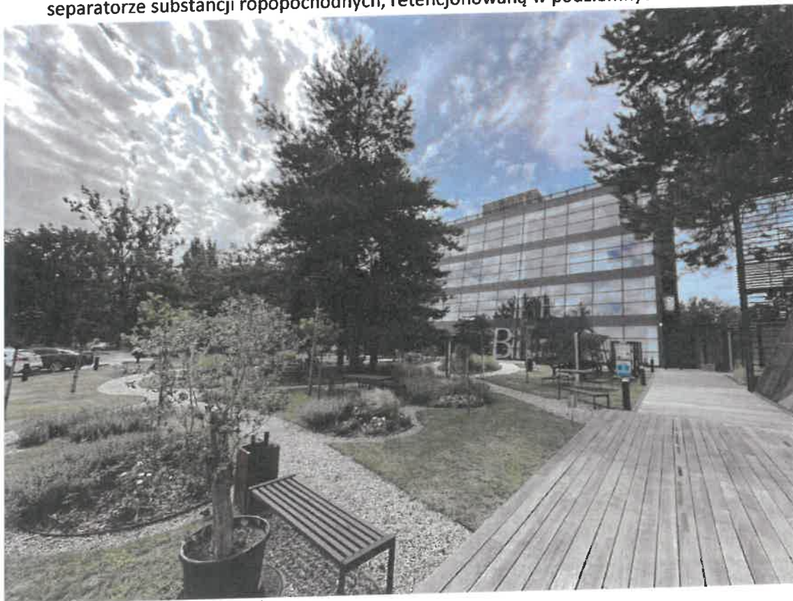
Fot. 3. Nowy budynek- Budynek B - WFOŚiGW w Łodzi.
