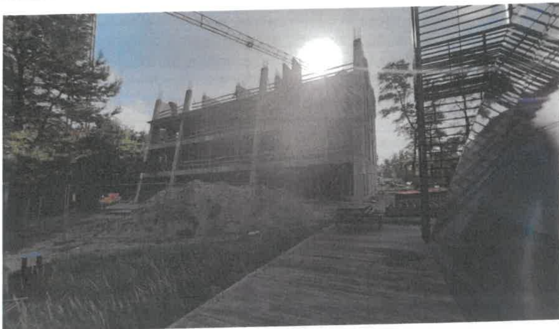
Fot. 12. Postęp prac budowlanych – budynek B.
