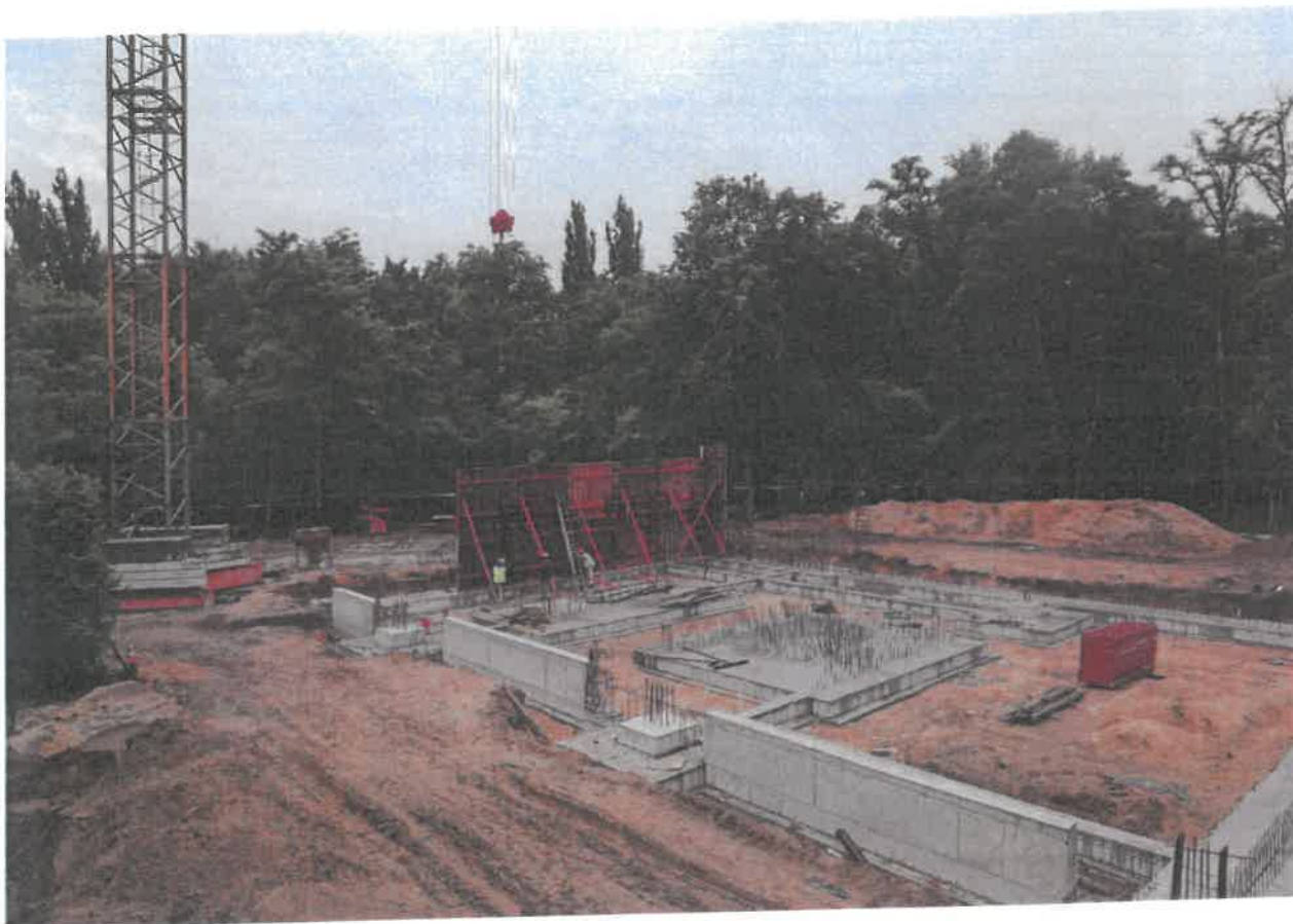
Fot. 10. Fundamenty pod budynek B.
