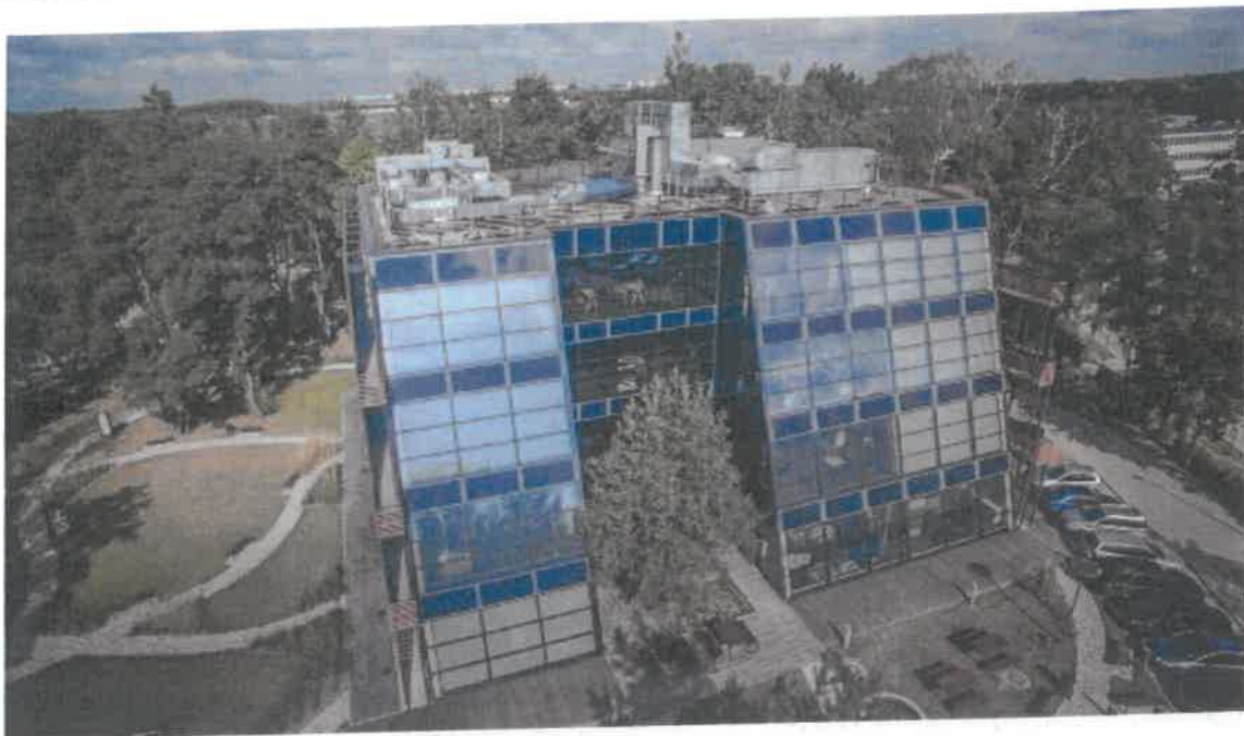
Fot. 8. Elewacja południowa budynku A WFOŚiGW w Łodzi.
