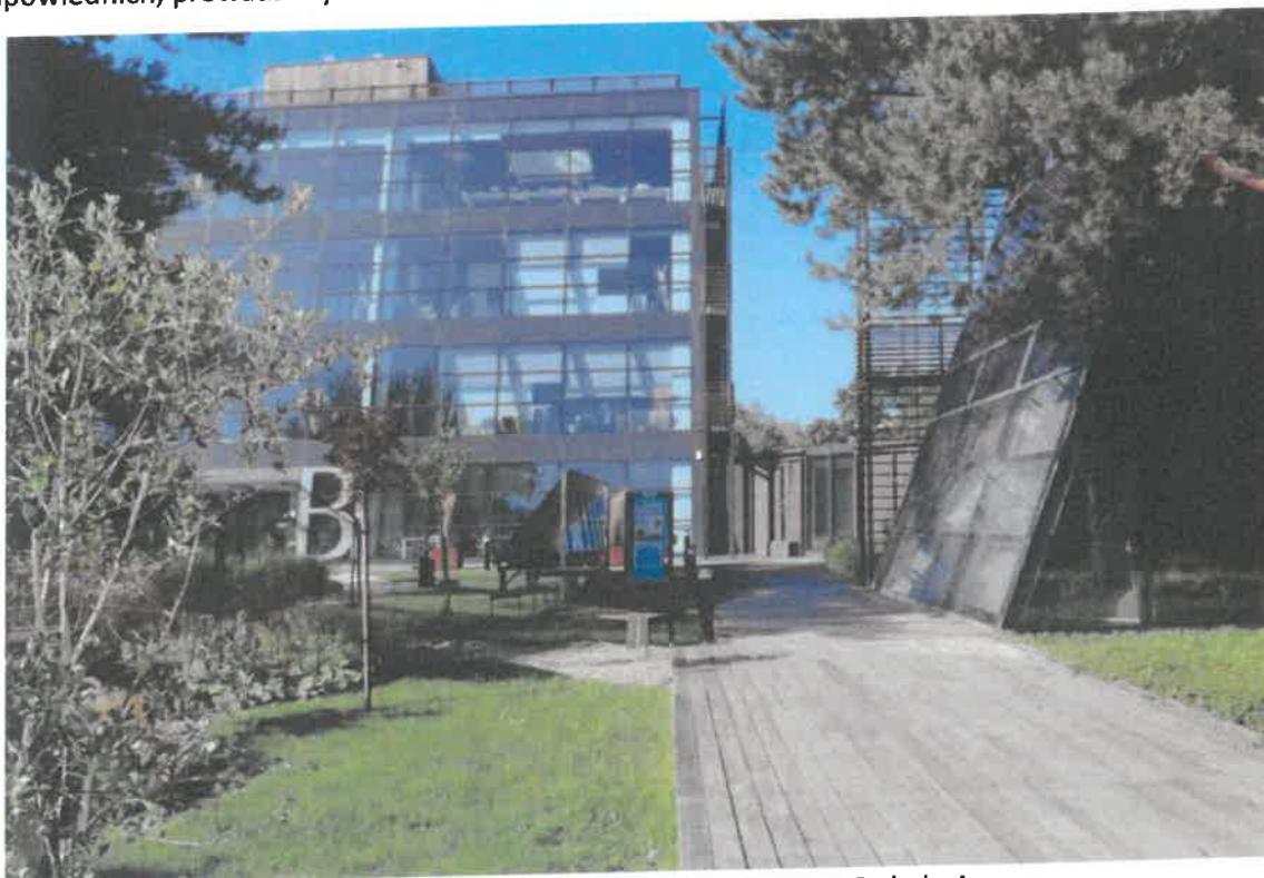
Fot. 13. Elewacja północno-wschodnia Budynku B wraz z łącznikiem i fragmentem Budynku A.
