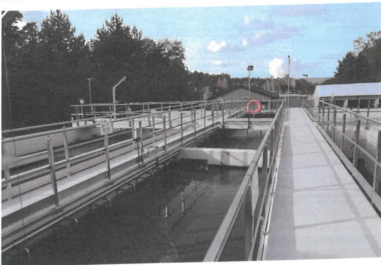
Fot. 20. Oczyszczalnia ścieków w Gomunicach
