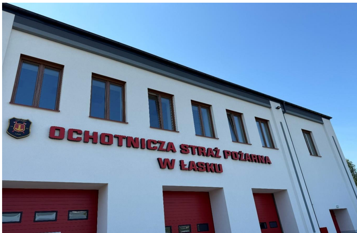
- Termomodernizacja budynku OSP w Łasku -
